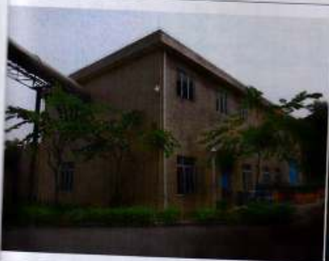
废水预处理车间
